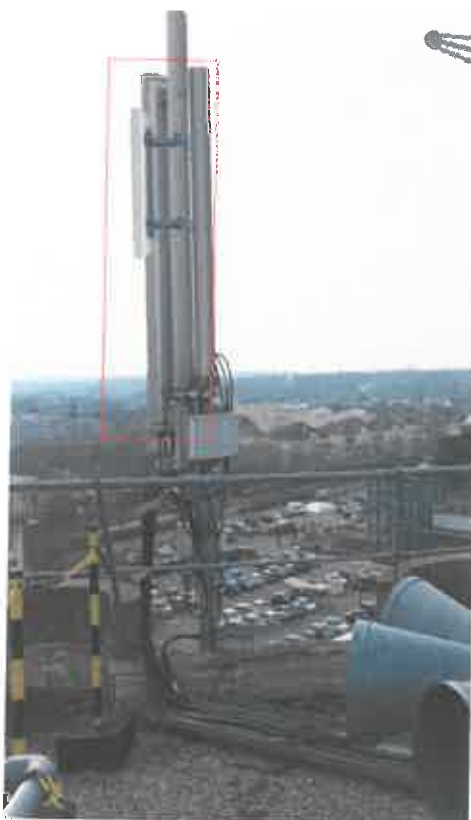
Vue de la terrasse S1 après travaux
