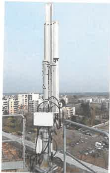
Vue de la terrasse S0 avant travaux
