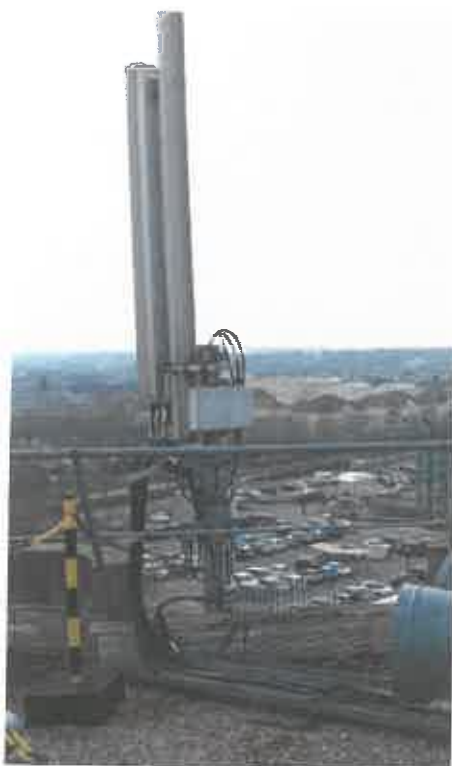
Vue de la terrasse S1 avant travaux
