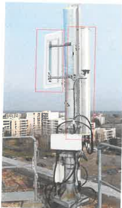
Vue de la terrasse S0 après travaux
