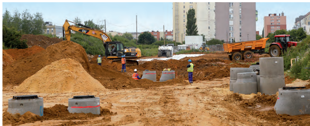
Pose de regards de visite.
