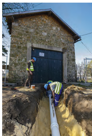
Pose d'un collecteur
