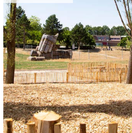
Travaux aux 7 Mares
