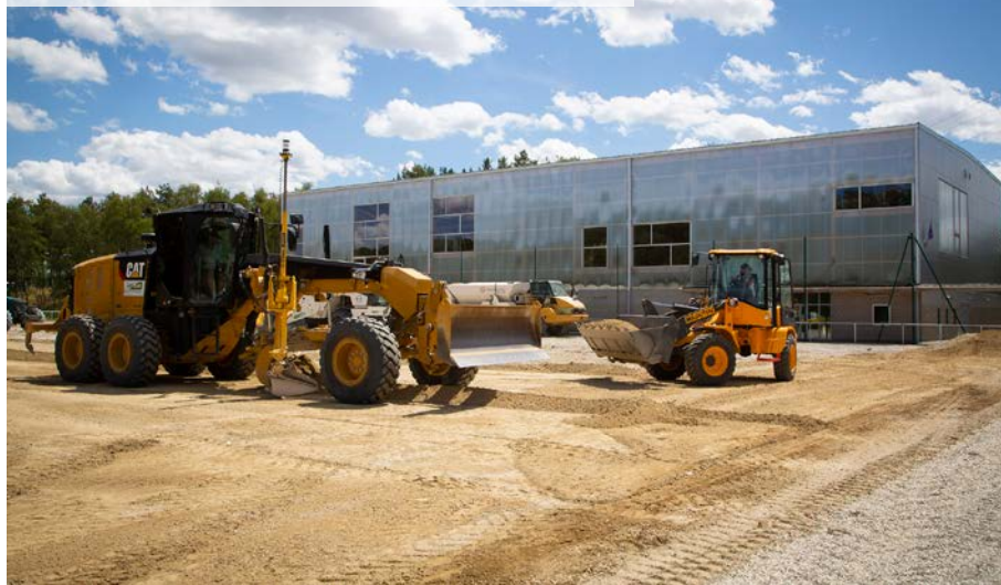
Travaux de remplacement du terrain synthétique à Coubertin
