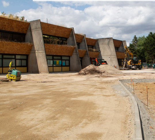
Création d'une cour végétalisée (Villedieu).
